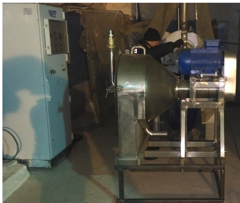
Рис. 3. Монтаж сита центробежного Ш12-УЦМ
