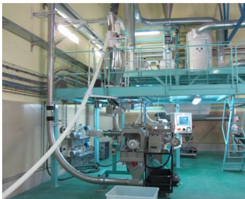
Рис. 6. Новый цех по производству экструзионного крахмала для буровых растворов на ОАО «Рогозницкий крахмальный завод»
