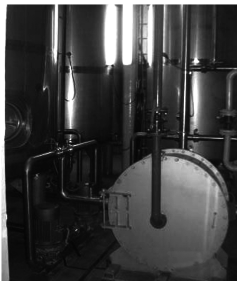
Рис. 6. Спиральный теплообменник Ш12-ТСБ/2
