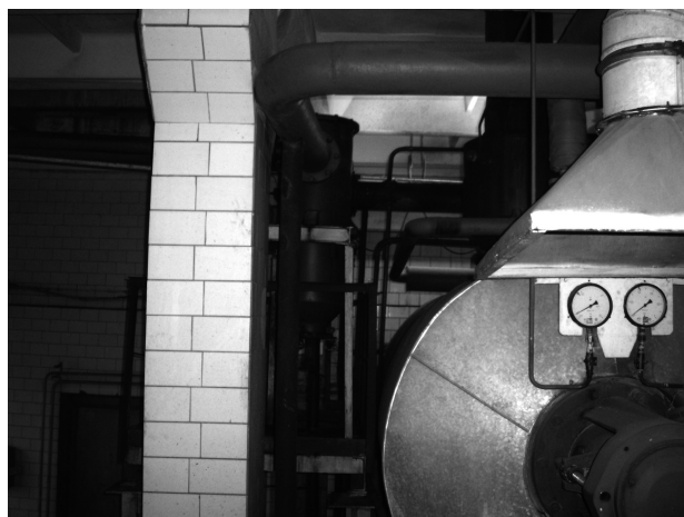
Рис 2. Горизонтальный вакуумный котел КВМ — 4,6
